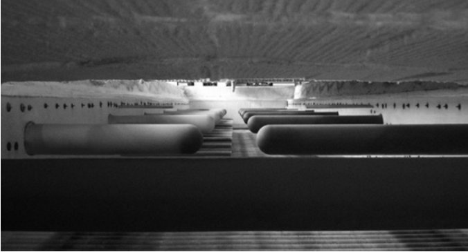
Tubes radiants en céramique SER-C dans le four à rouleaux pendant les travaux de montage
