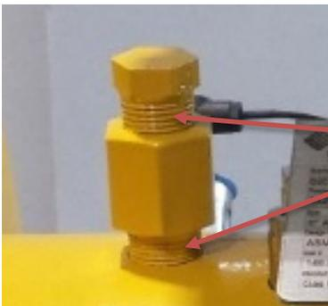
Diese Stellen müssen auf ihre Dichtigkeit hin geprüft werden, wenn ein neuer Druckanschluss installiert wurde.
