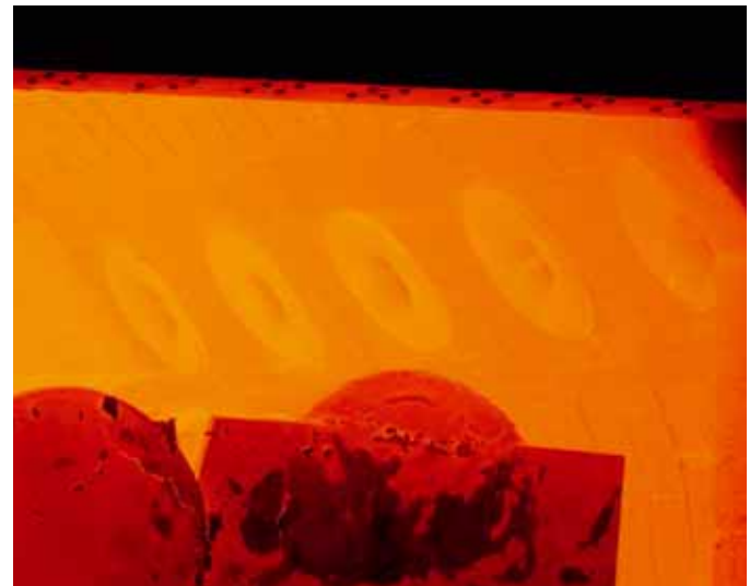
Bild 4: Neue Flachflammenbrenner in einem Herdwagenofen Fig. 4: Flat flame burner in a bogie hearth furnace
