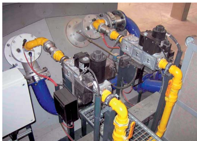
Bild 1: Typischer Aufbau einer Beheizungseinrichtung im pneumatischen Verbund
