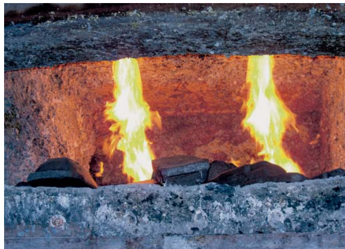
Bild 4: Aluminiumschmelzofen im Kleinlastbetrieb. Der Ofen ist bestückt mit Aluminiummasseln. Betrieben durch zwei ZIO 165 Elster Kromschroder Brenner, Nennleistung je Brenner 630 kW
