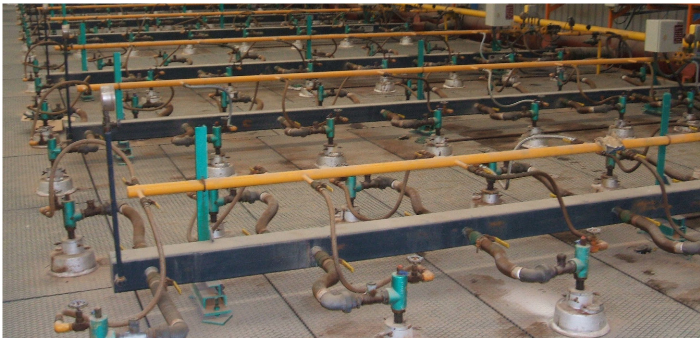
Extenso-Heat-Lanzenbrenner auf dem Dach eines Keramik-Tunnelofens installiert
