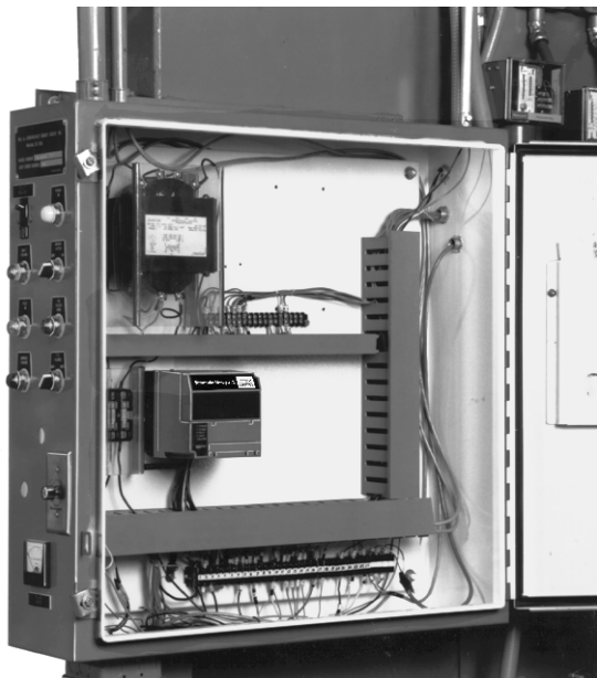
図 8. 電気パネルの取付
