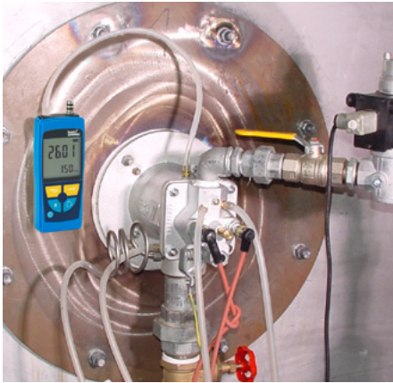
Un aimant au dos de l'appareil permet une utilisation mains libres lors des travaux de réglage sur le brûleur par exemple.
