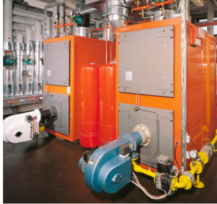
Pour le réglage des brûleurs gaz
