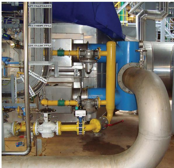
模块化燃烧器的灵活性、一体混合器结构、简化的控制技术，使 Linnox ULE 燃烧系统成为各种风道加热应用的世界级选择。对于特殊的应用，工程可选项还包括涂装或不锈钢结构。
