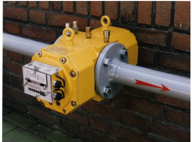
Bild 1: Durchflussrichtung von Links nach Rechts
