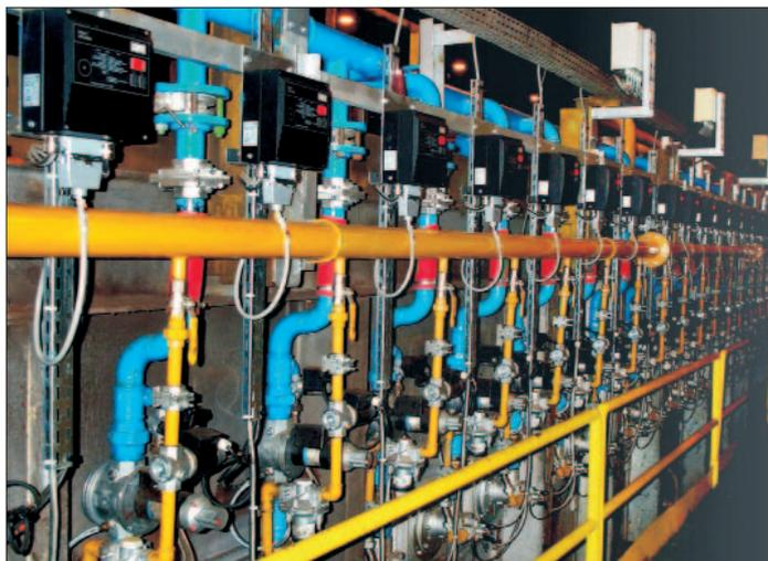
**Bild 3:** Beheizungseinrichtung mit Brennersteuerung BCU
