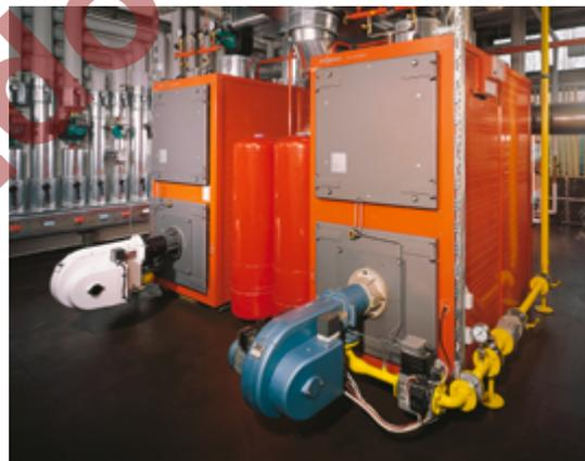
*Überwachung des Gaseingangsdruk an Heizkesseln mit größerer Leistung*
