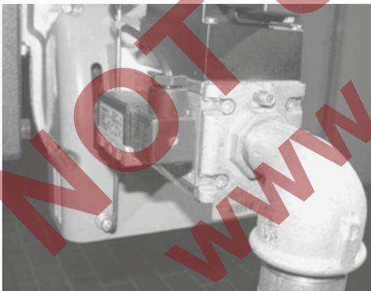
*Zur Gaseingangsdruküberwachung am Heizbrenner*
