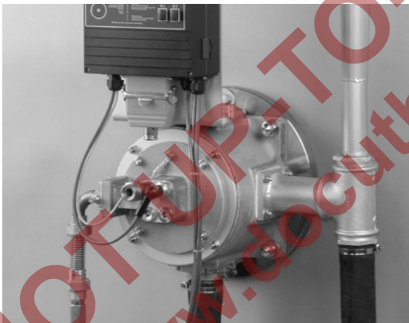
*BCU en quemador en tubo radiante*
