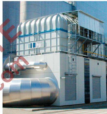
*Installation de postcombustion pour l'épuration thermique régénérative de l'air d'échappement*
