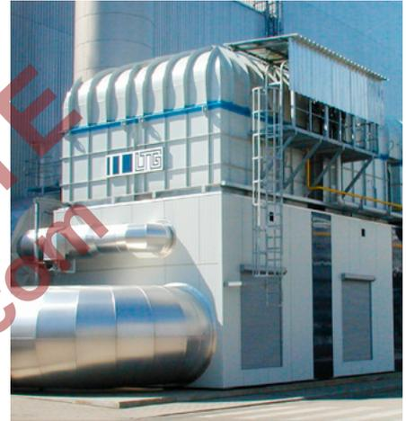
Nachverbrennungsanlage für thermisch-regenerative Abluftreinigung
