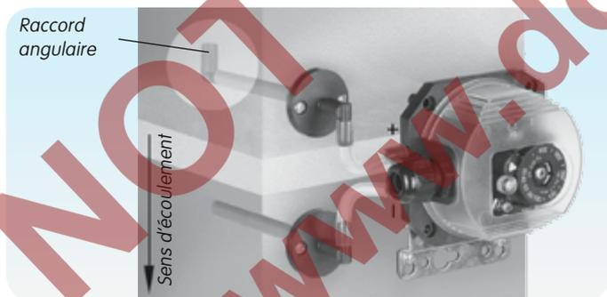
Le raccord angulaire renforce le signal  $\Delta p$ , lorsque celui-ci est trop bas pour la plage de réglage du pressostat.
