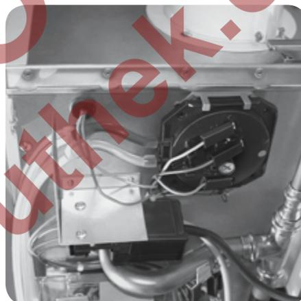
Pressostat DL fixé sur la chaudière par clip D
