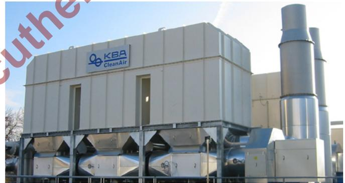
*Installation de postcombustion pour l'épuration thermique régénérative de l'air d'échappement*
