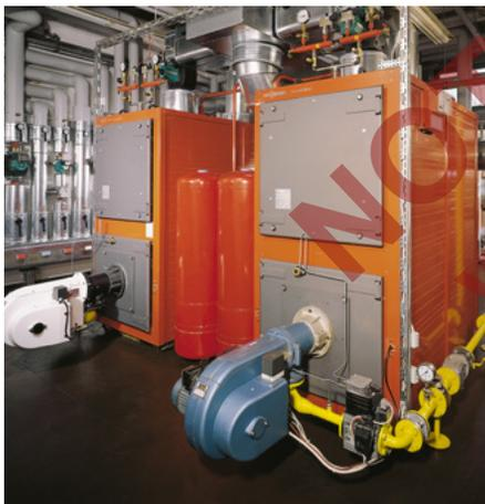
Control de la presión de entrada del gas en calderas de calefacción de mayor potencia
