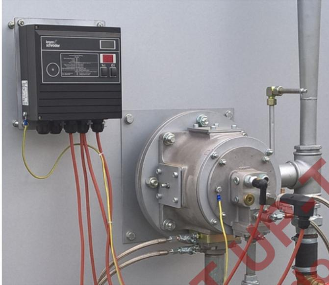
ECOMAX-Brenner mit Brennersteuerung BCU
