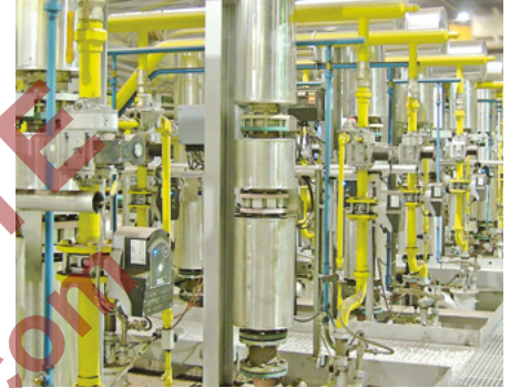
Four à longerons mobiles avec voûte radiante
