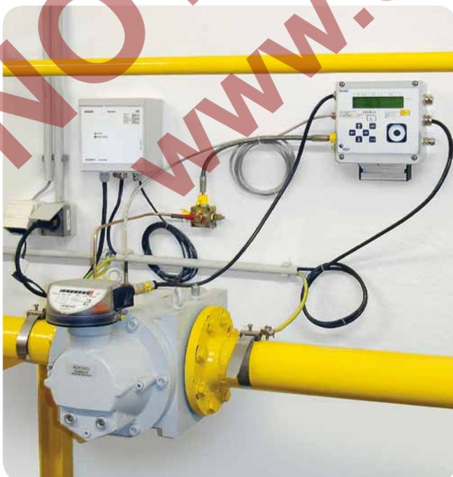
Abb. 2: Installation EK260 mit Modem EM260 ...
