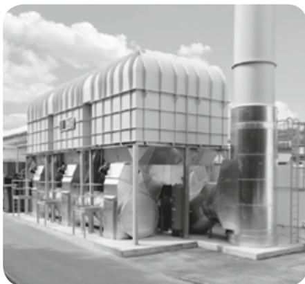
Installation de postcombustion pour l'épuration thermique régénérative de l'air d'échappement
