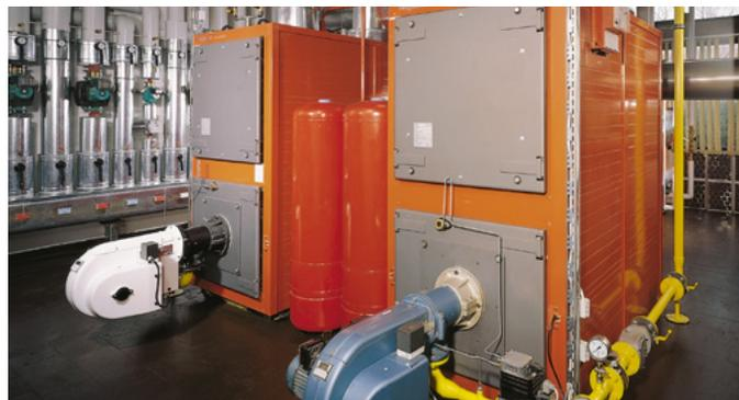
*Control de la presión de entrada del gas en calderas de calefacción de mayor potencia*
