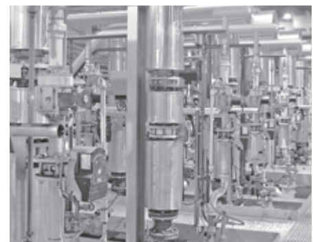
Four à longerons mobiles avec voûte radiante
